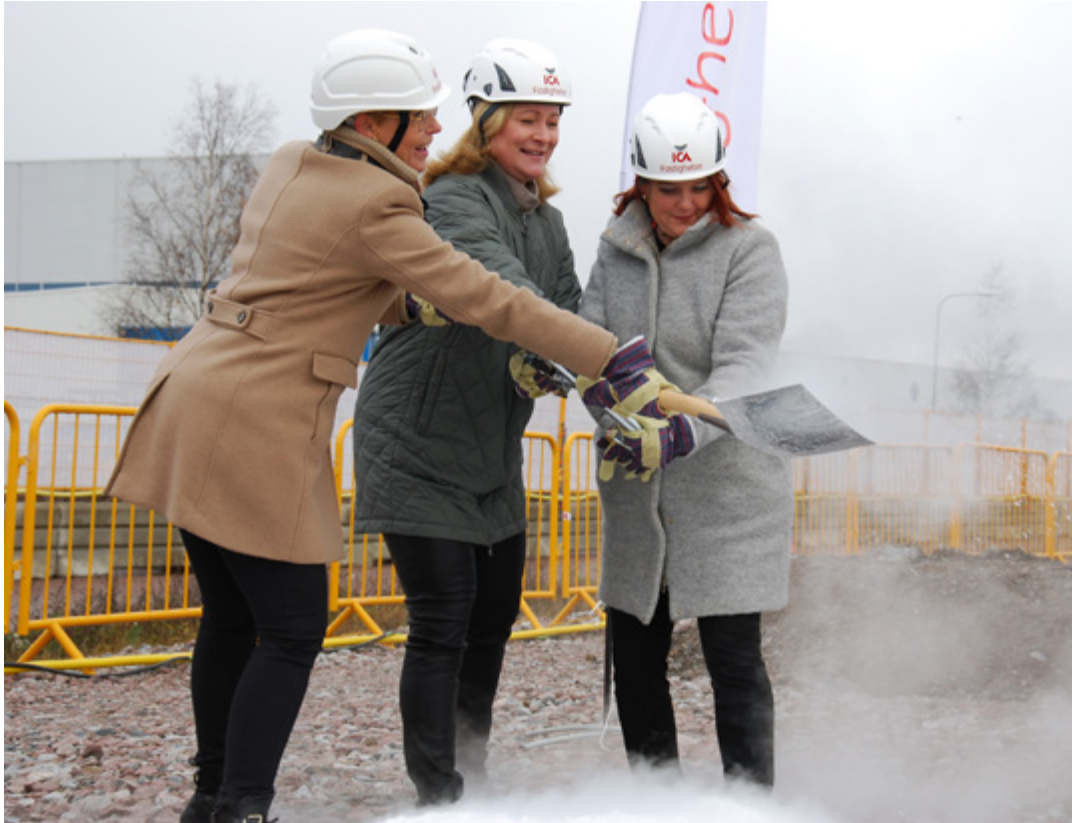
I november togs det första spadtaget till det högautomatiserade fryslagret i Västerås. Fr.v: Emma Lindström, ICA, Anna Nyberg, vd ICA Fastigheter och Amanda Grönlund, kommunstyrelsens vice ordförande i Västerås Stad.
